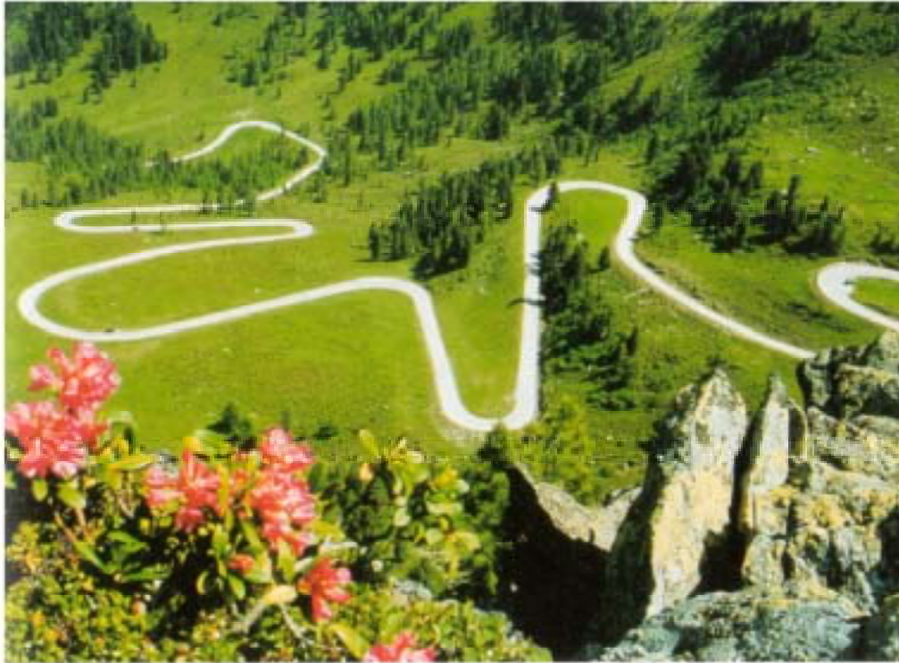
Kärnten. Blick auf den Schiestelboden, wo die Nockalmstraße → Kz 50 in neun großzügig angelegten Kehren zur Schiestelscharte (2015) ansteigt. Am dortigen Parkplatz wurde eine informative Nationalparkschau errichtet. Foto GROHAG
